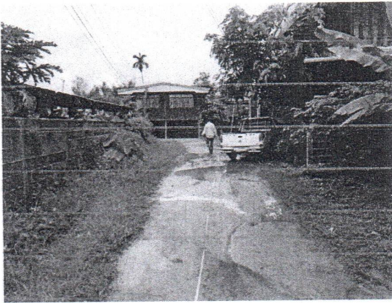
- ถนนคอนกรีตเสริมเหล็ก
